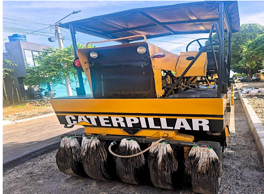
Fotografía No. 1 Vista Frontal
