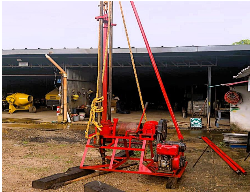
Fotografía No. 1 Vista Frontal
