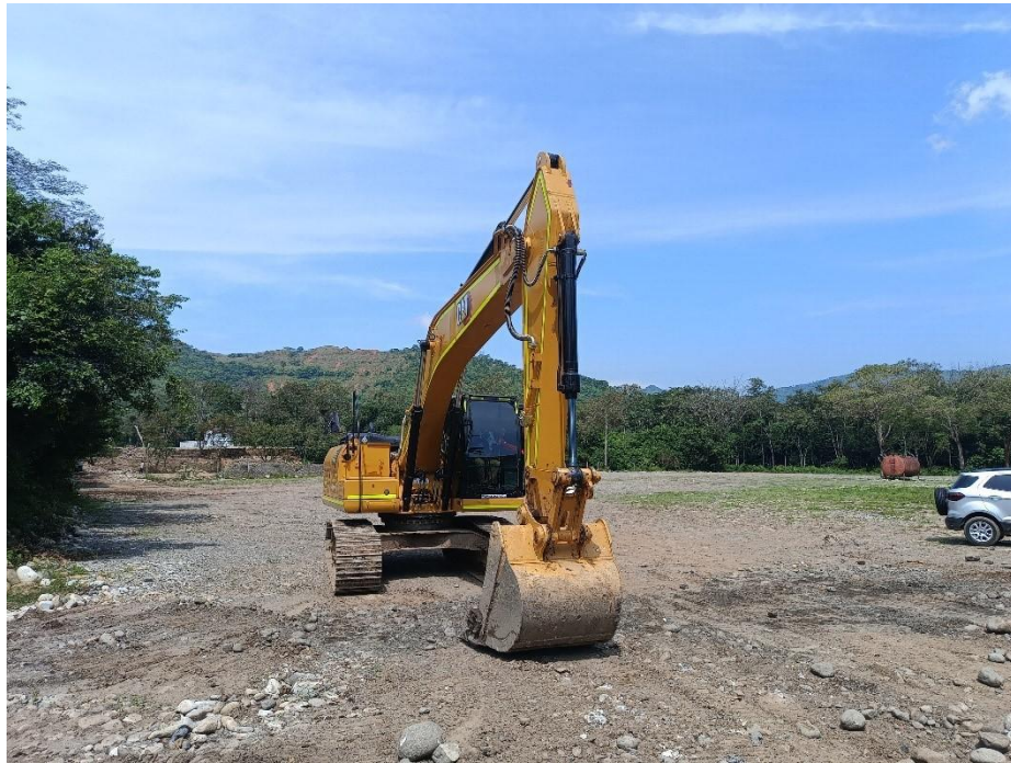
Fotografía No. 3 Vista Frontal
