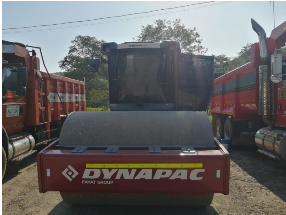
Fotografía No. 3 Vista Frontal
