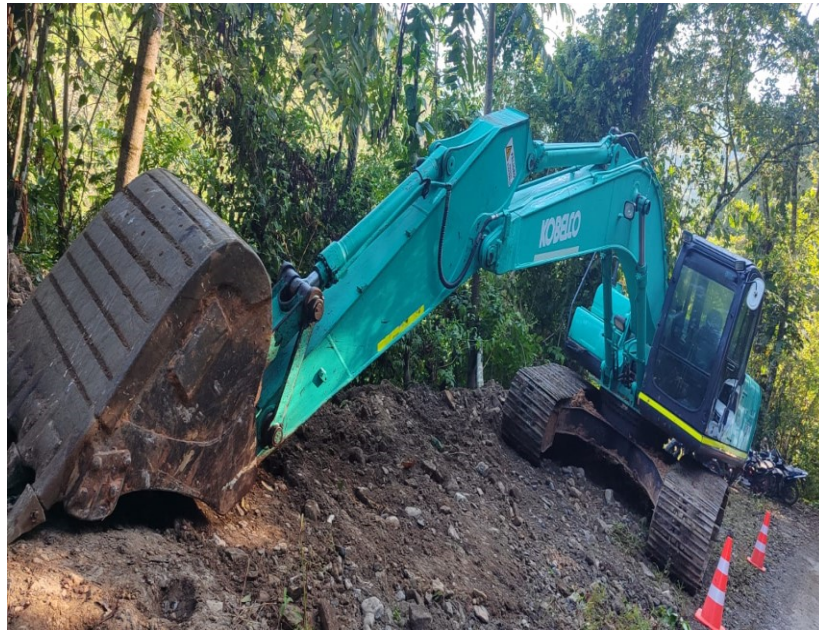
Fotografía No. 3 Vista Frontal
